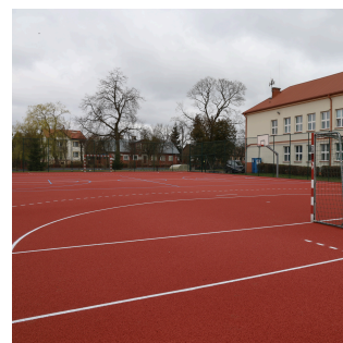
Modernizacja boiska przy Zespole Szkolno Przedszkolnym str.5
