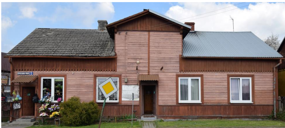
widok w kierunku zachodnim
