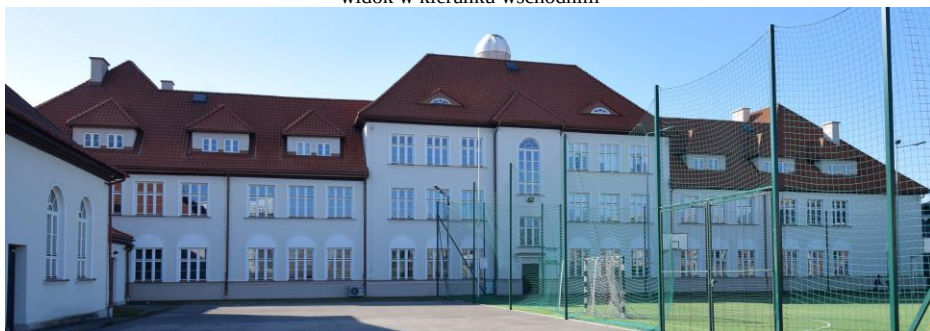
widok w kierunku północno-zachodnim
