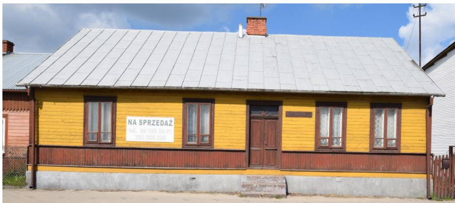
widok w kierunku zachodnim
