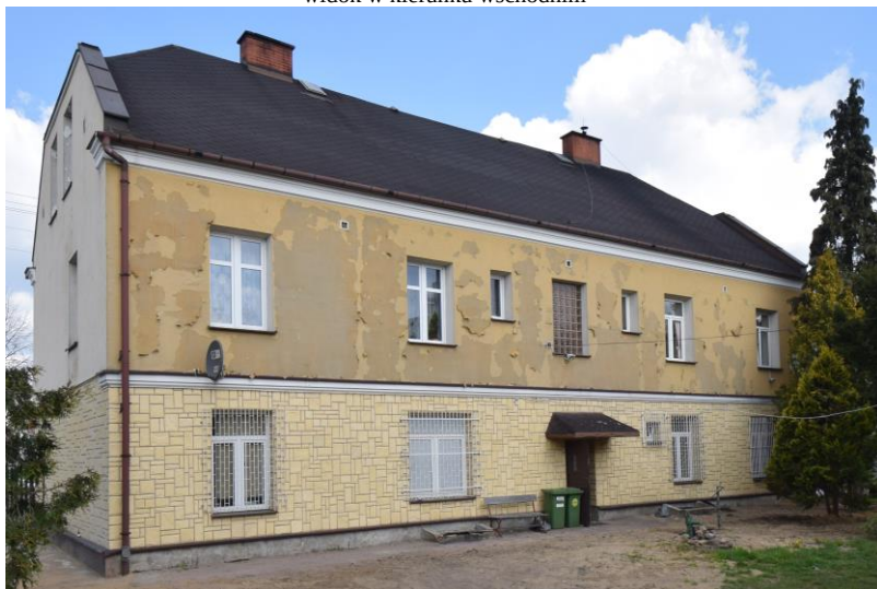
widok w kierunku północno-zachodnim
