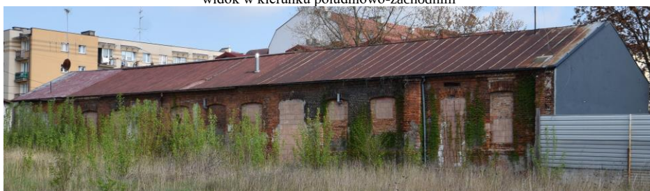
widok w kierunku północno-zachodnim
