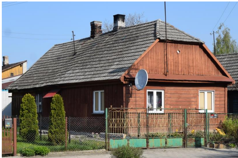
widok w kierunku północno-zachodnim
