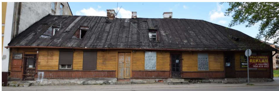
widok w kierunku północno-zachodnim
