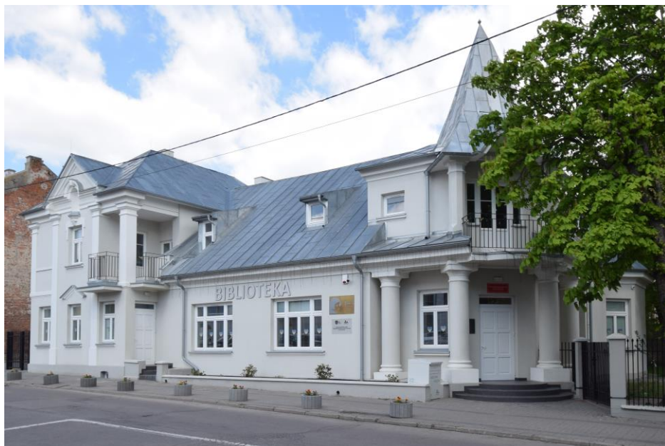
widok w kierunku północno-zachodnim
