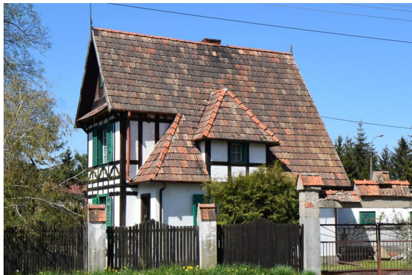
widok w kierunku północno-zachodnim
