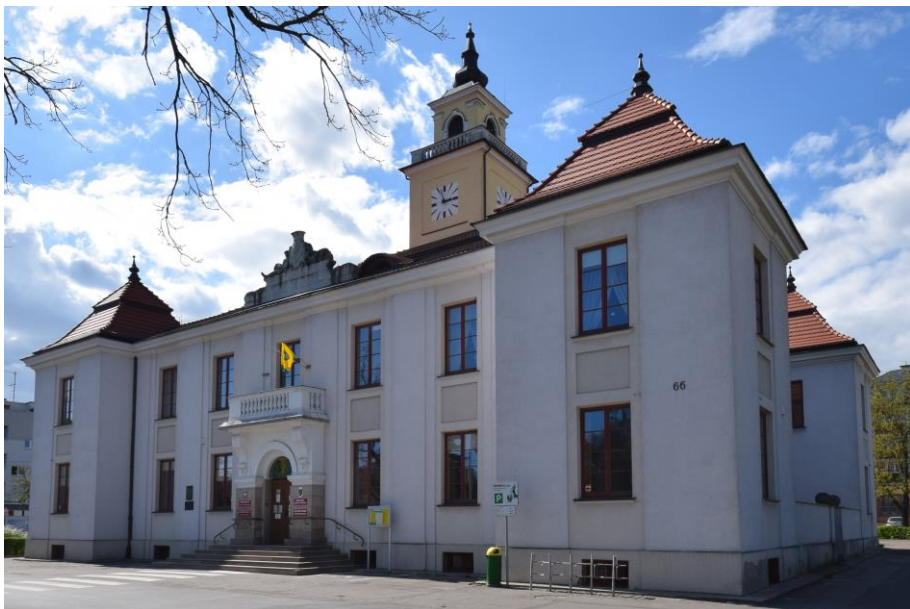
widok w kierunku zachodnim
