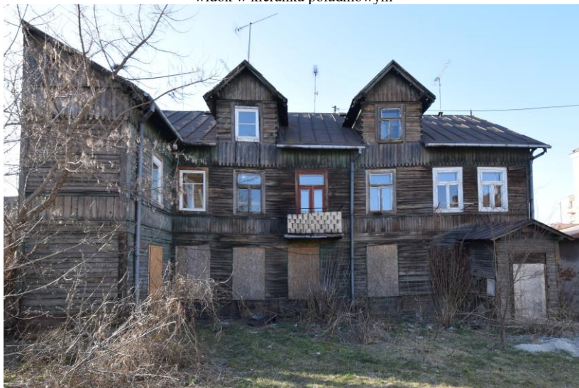
widok w kierunku północno-zachodnim
