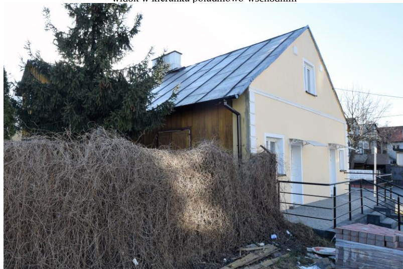
widok w kierunku zachodnim
