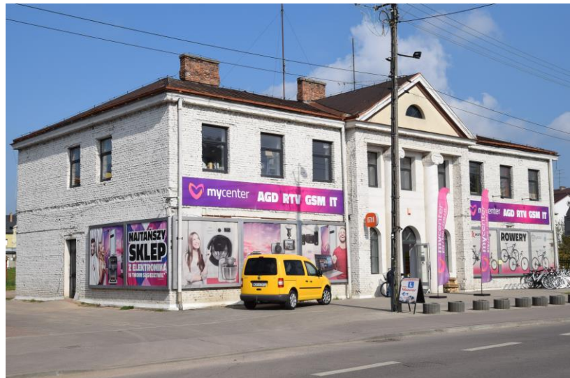
widok w kierunku północno-zachodnim
