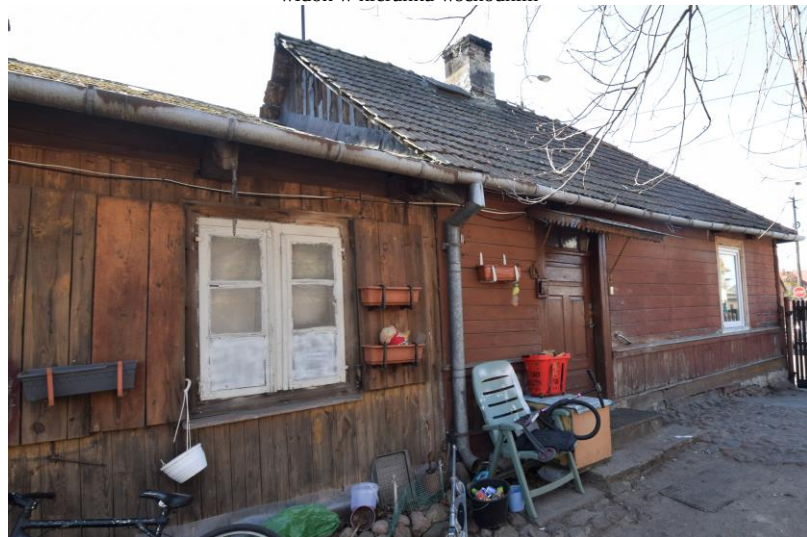
widok w kierunku zachodnim
