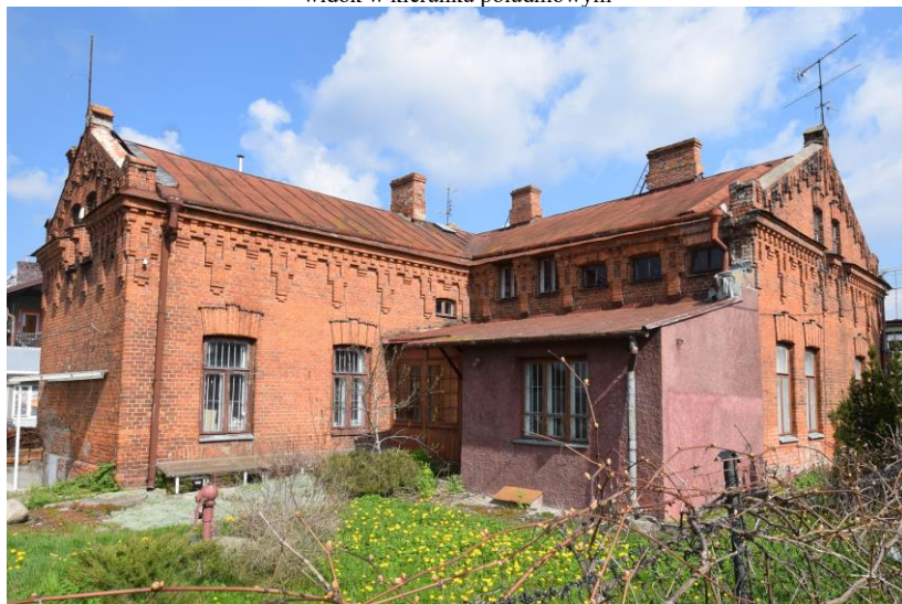
widok w kierunku północno-zachodnim
