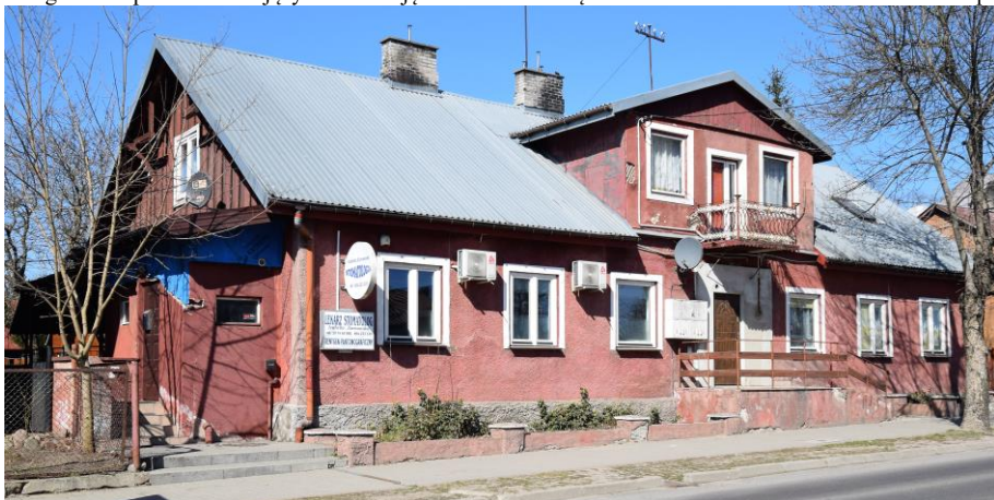
widok w kierunku północno-zachodnim
