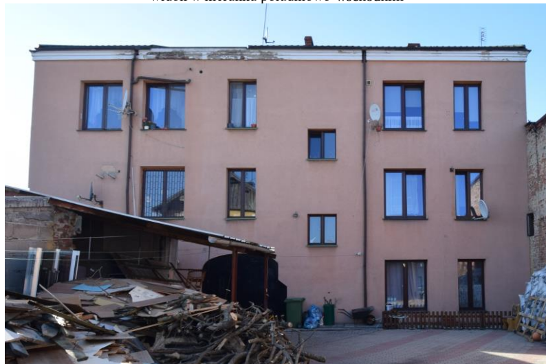
widok w kierunku północno-zachodnim
