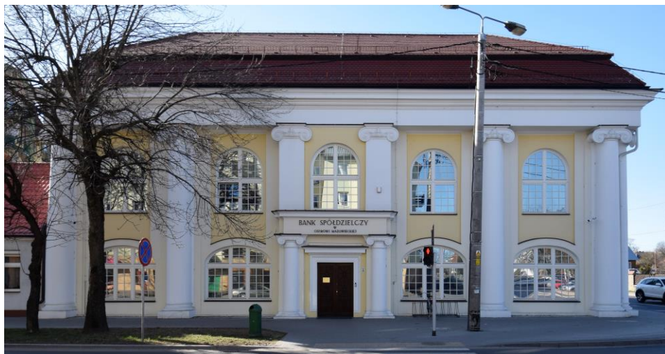
widok w kierunku zachodnim
