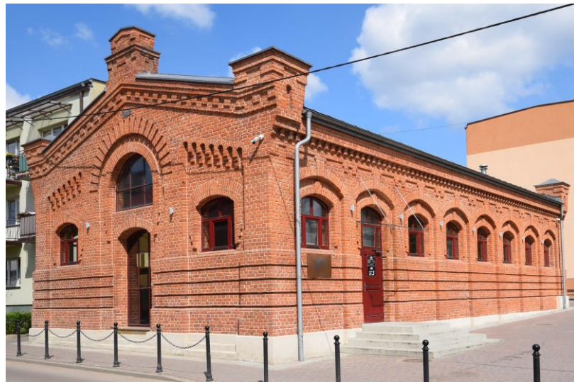
widok w kierunku północno-zachodnim
