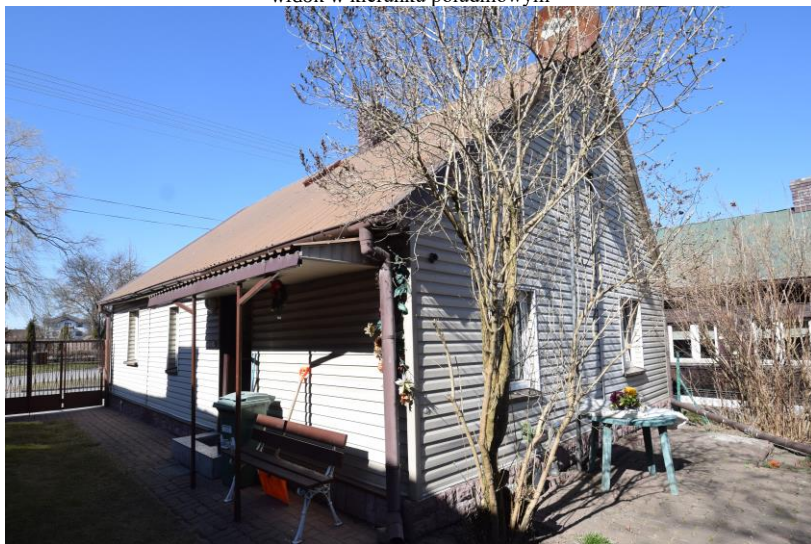
widok w kierunku północno-zachodnim
