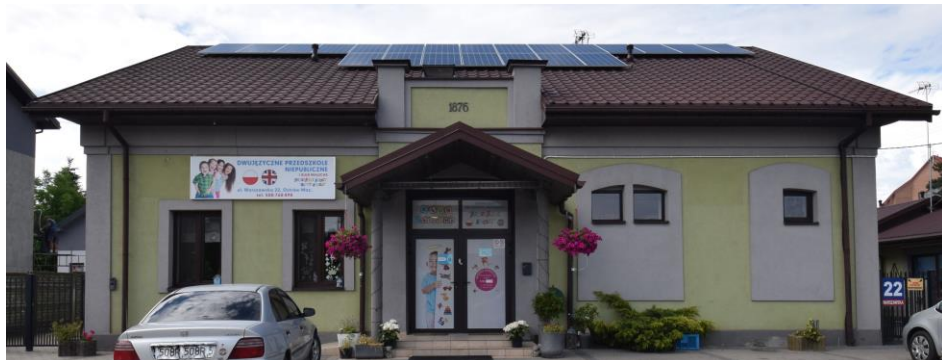
widok w kierunku północno-zachodnim
